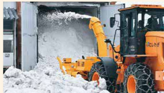
雪を吹き付けながら雪室に詰めていく除雪機
