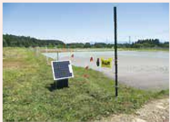
設置が完了した圃場
