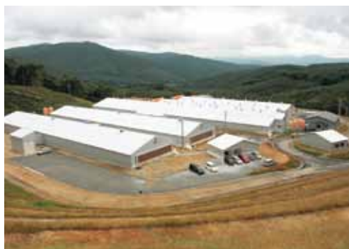
左から交配舎、妊娠ストール舎、分娩舎1棟と小豚舎2棟
