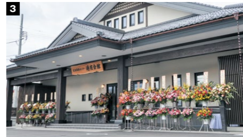
1.テープカットで完成を祝いました 2.玉串を奉奠した高橋組合長 3.完成した通夜会館
