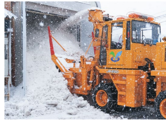
「雪室」に除雪機で雪を詰め込む
